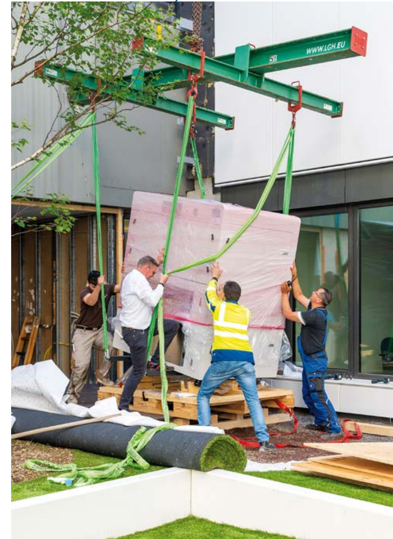
Passte durch keine Tür: Für die Anlieferung des 1,4 Tonnen schweren Druckers musste die Fassade des UKM geöffnet werden.
